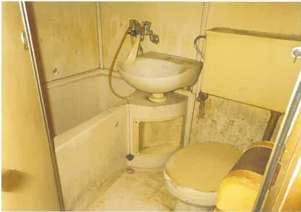
物件9:1階107号室の浴室・便所の状況
