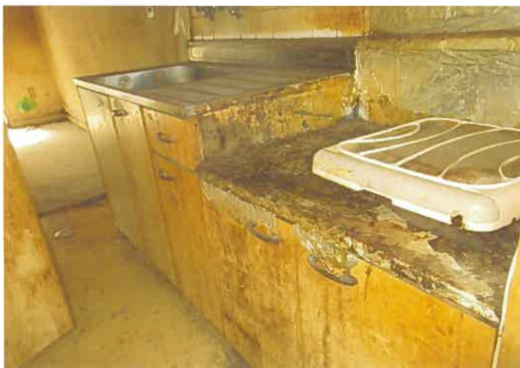
物件9:1階107号室の廊下・流し台等の状況
