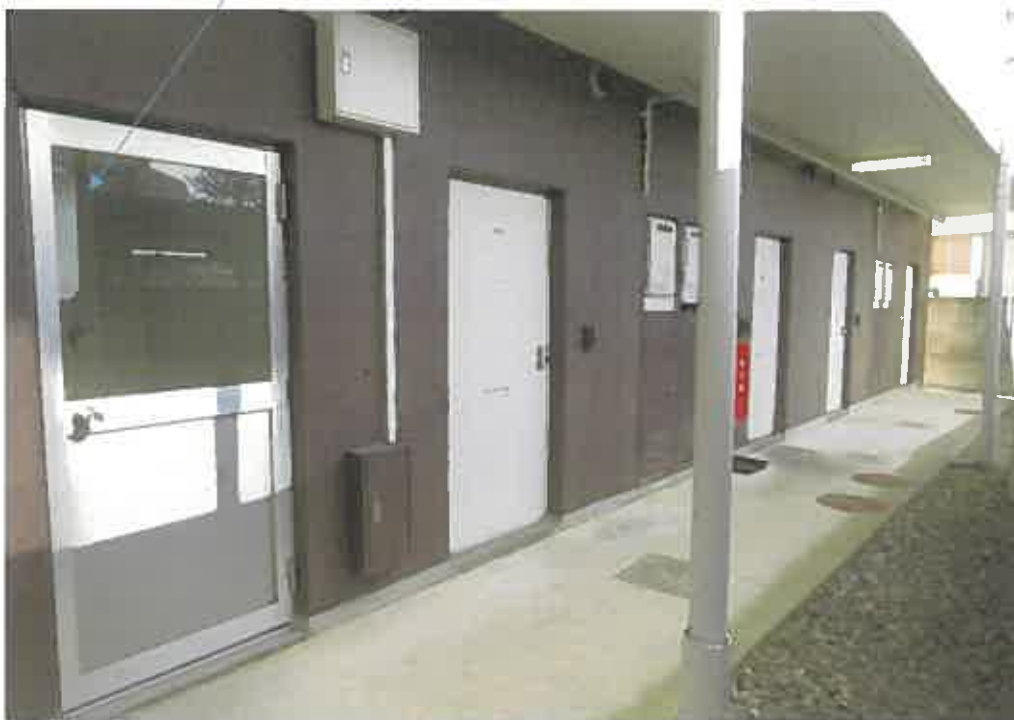
物件9:1階外廊下の状況
