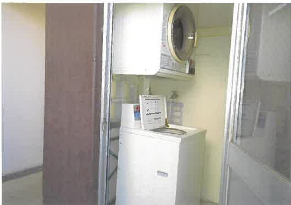
物件9:1階コインランドリー室の状況
