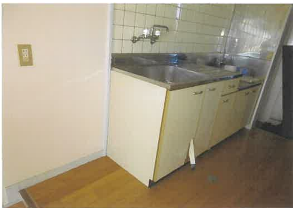
物件9:3階307号室の廊下・流し台等の状況
