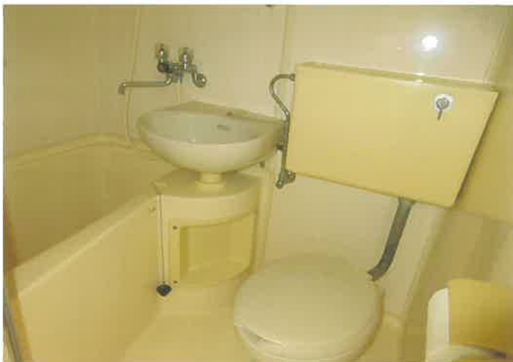
物件9:3階307号室の浴室・便所の状況
