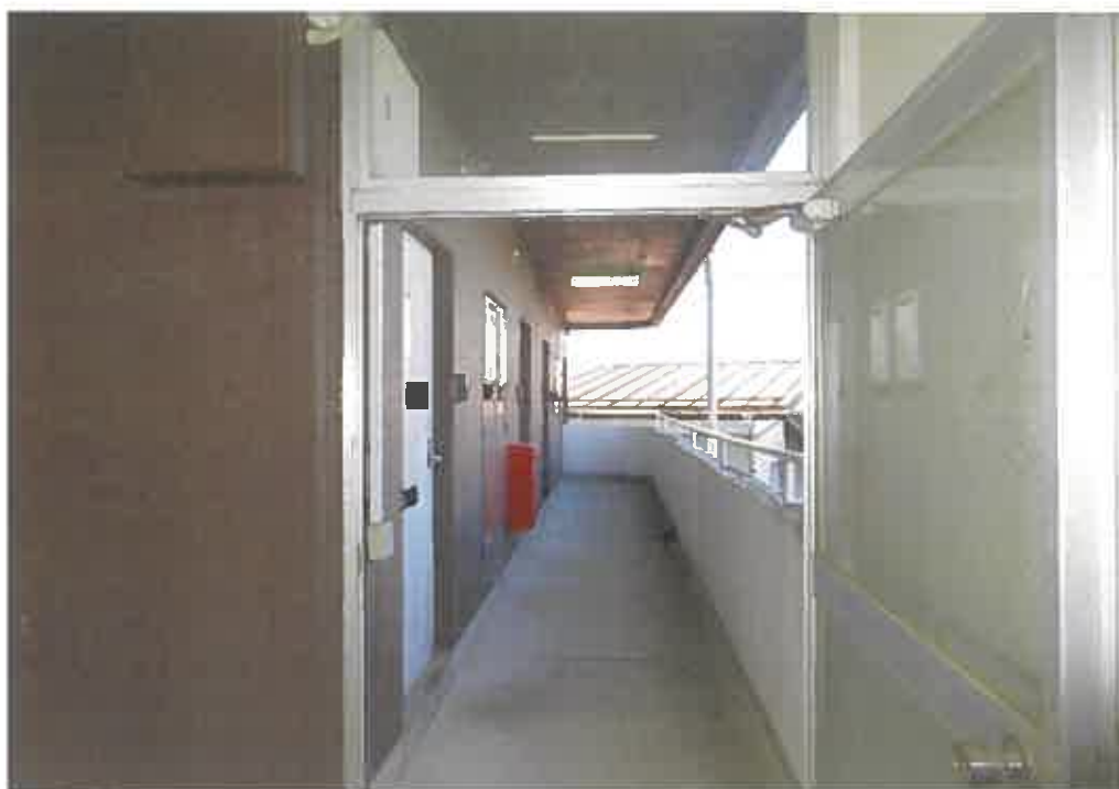
物件9:3階外廊下の状況
