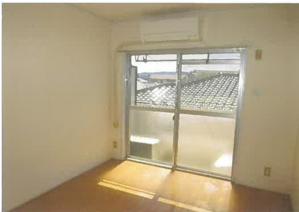
物件9:3階307号室の洋室の状況
