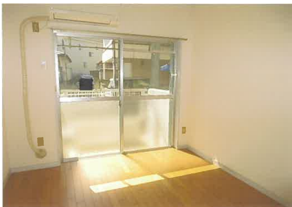
物件9:1階103号室の洋室の状況
