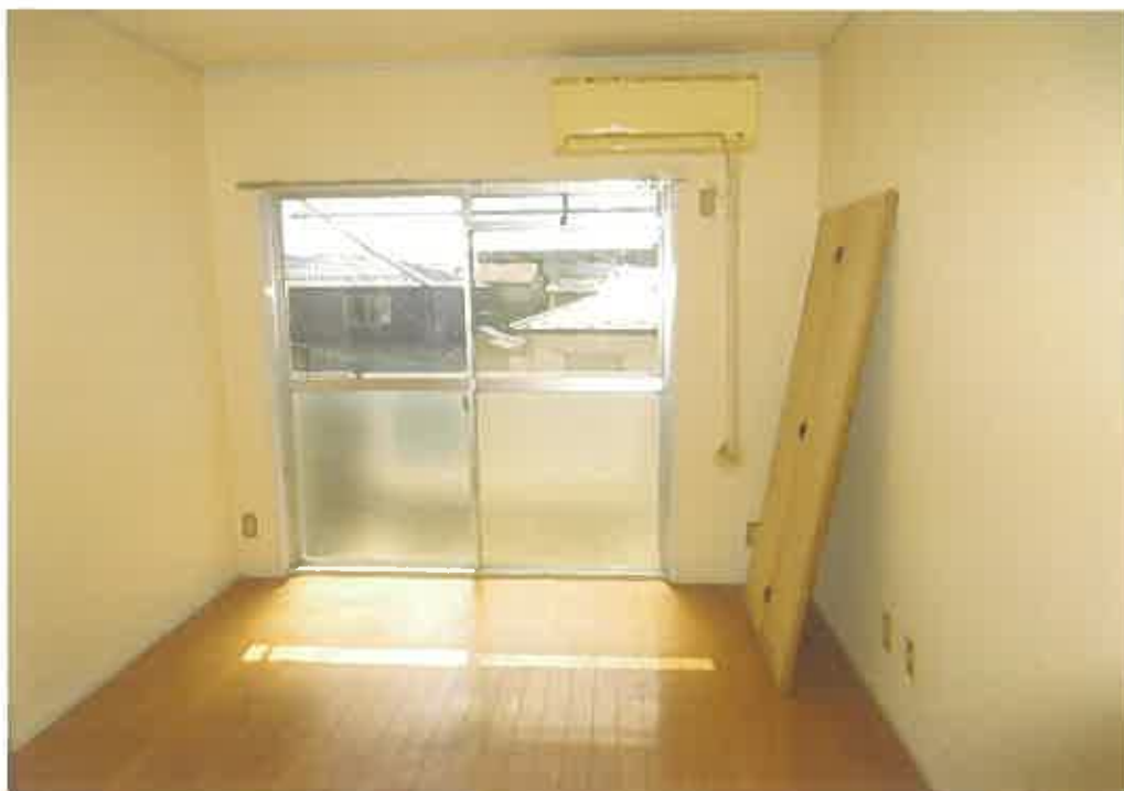
物件9:3階302号室の洋室の状況
