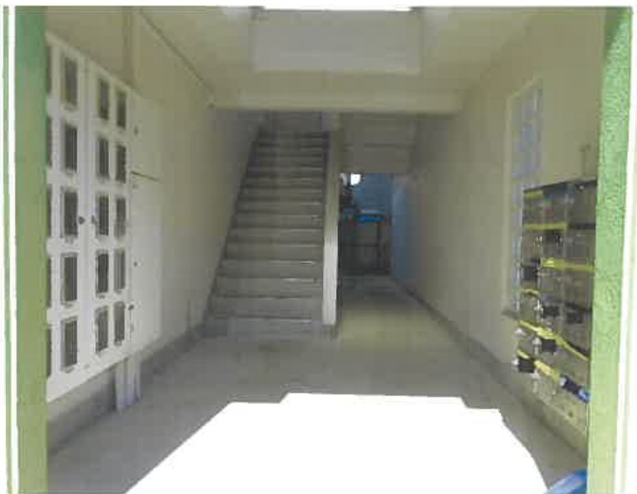
物件9:1階ホール等の状況
