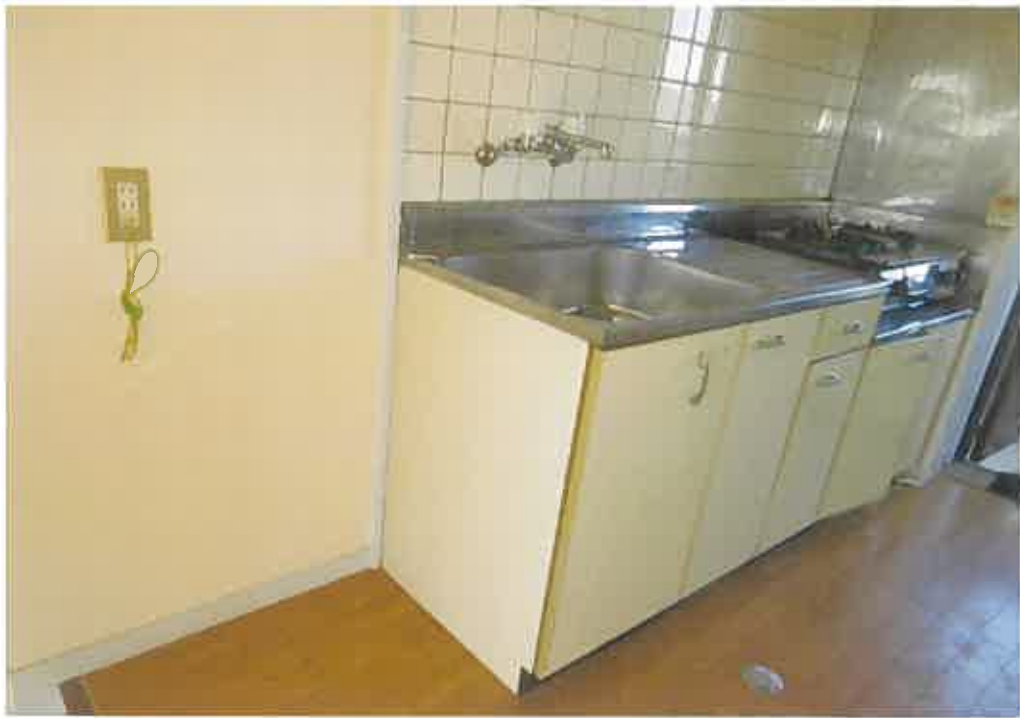
物件9:3階302号室の廊下・流し台等の状況
