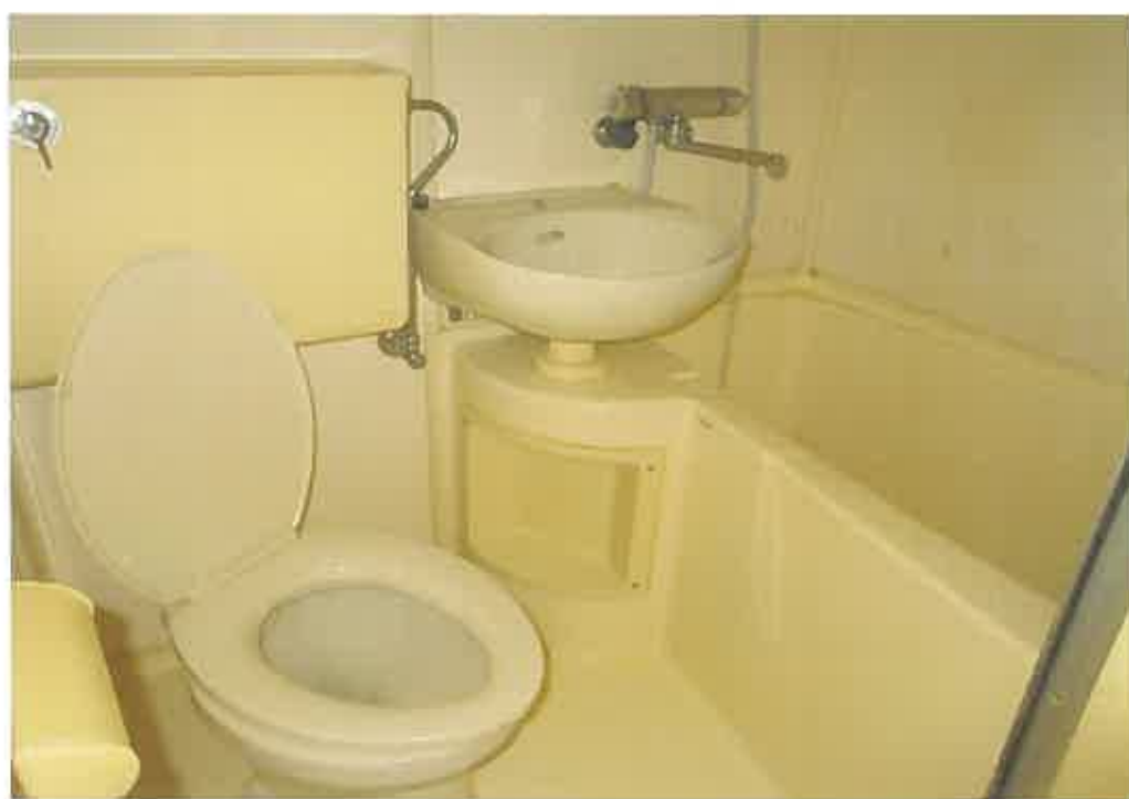
物件9:1階103号室の浴室・便所の状況
