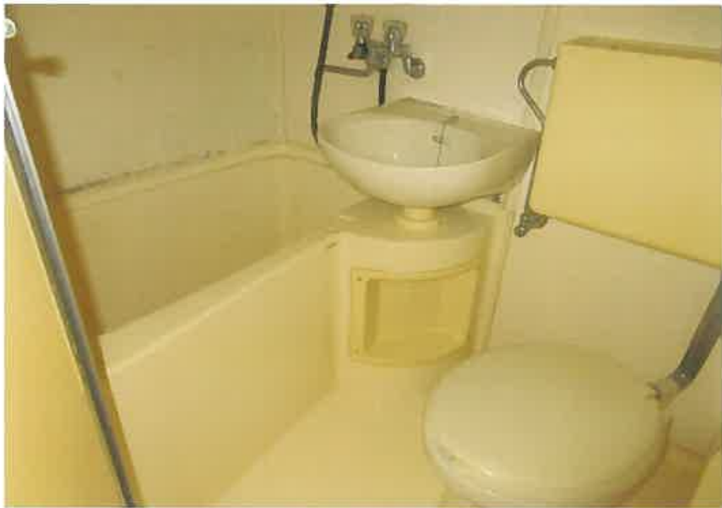
物件9:2階202号室の浴室・便所の状況
