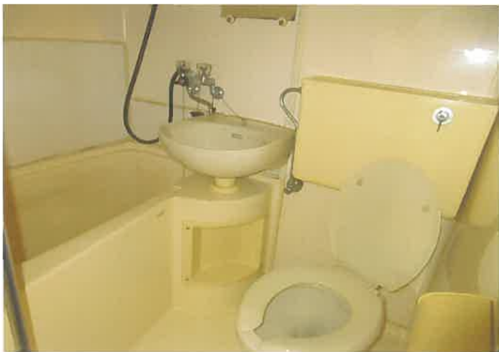
物件9:2階207号室の浴室・便所の状況
