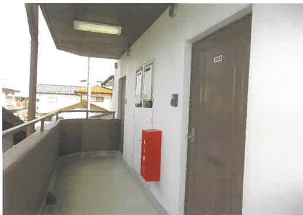
物件9:2階外廊下の状況
