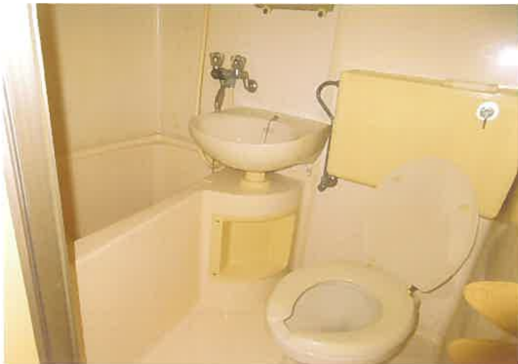
物件9:3階302号室の浴室・便所の状況
