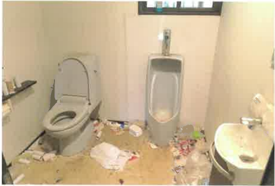
物件2主である建物: 1階トイレの状況
