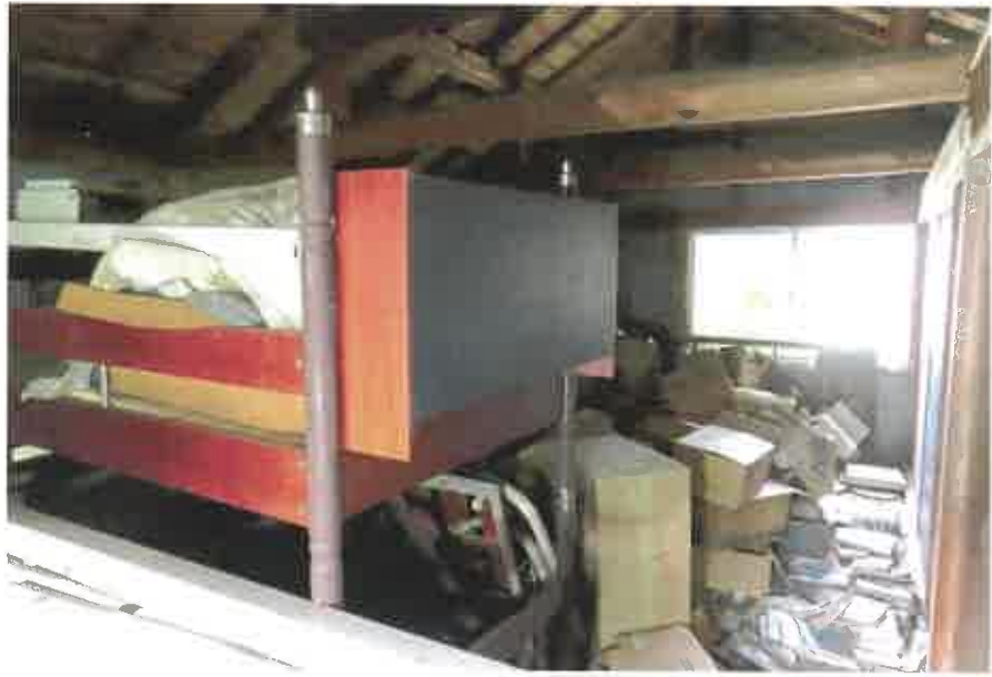
物件2附属建物符号1:2階物置の状況
