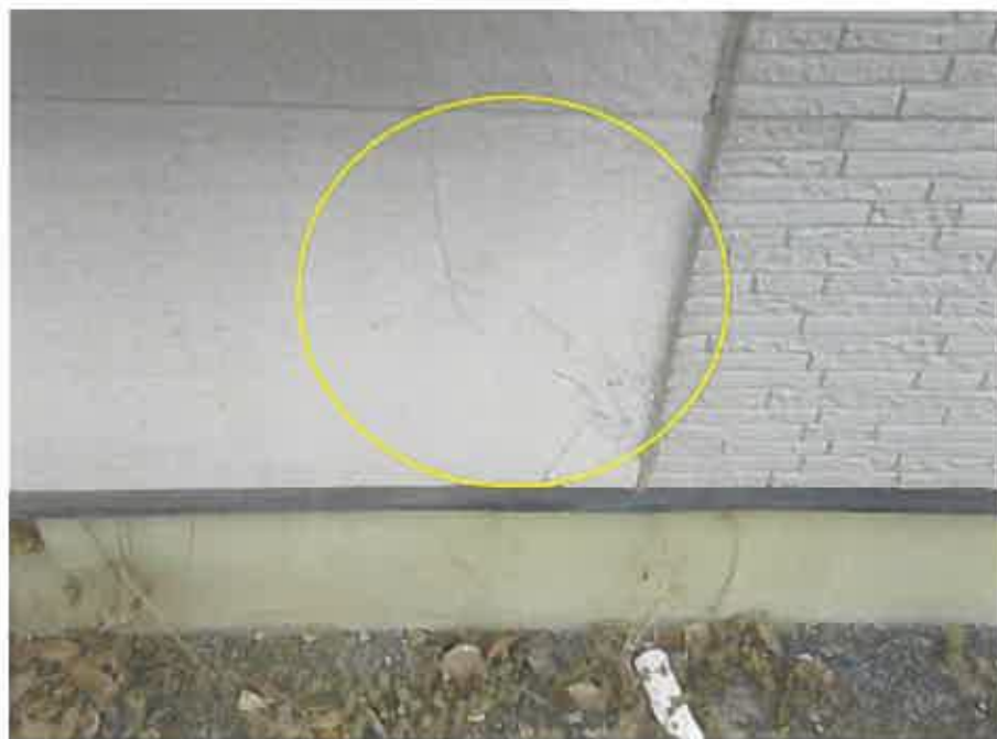
物件4:外壁の損傷箇所
