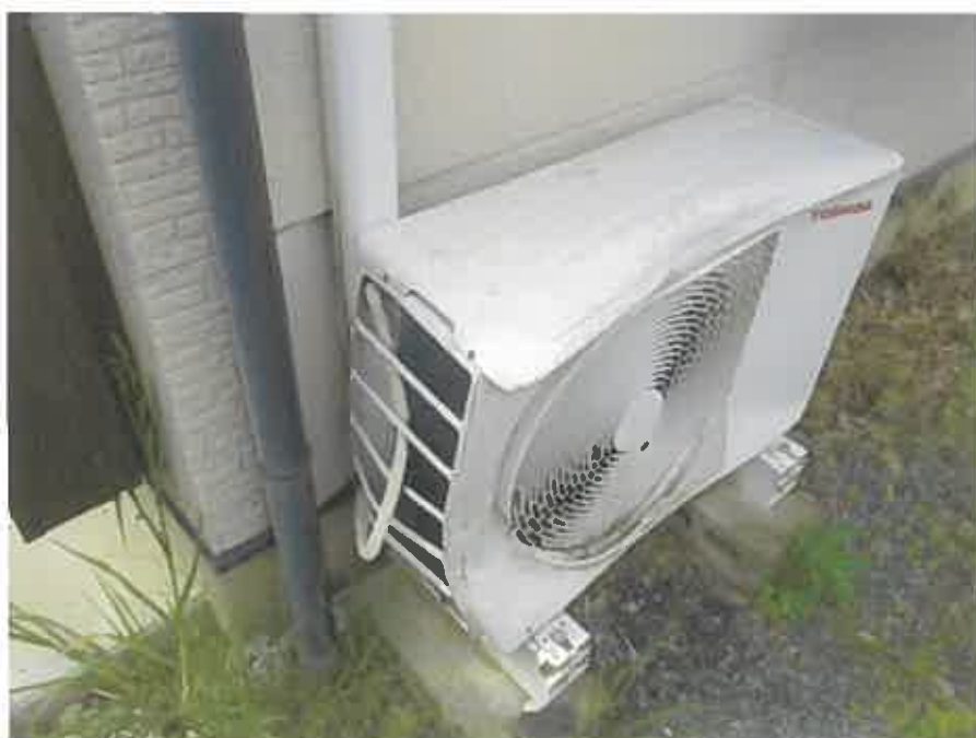
物件4に設置された室外機の損傷具合
