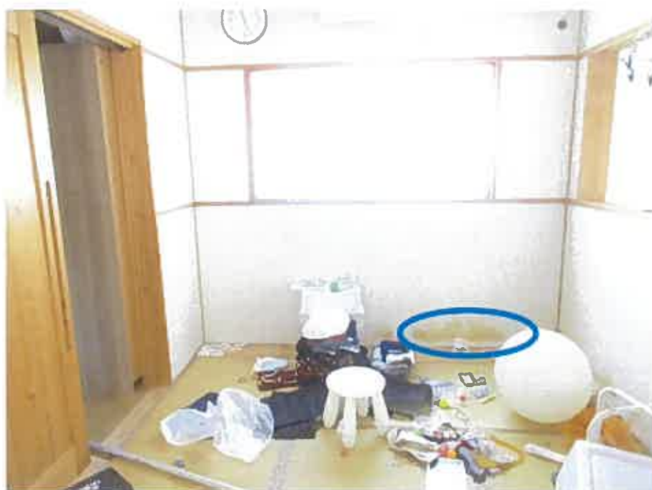
物件4:2階和室と内壁の剥離の状況
