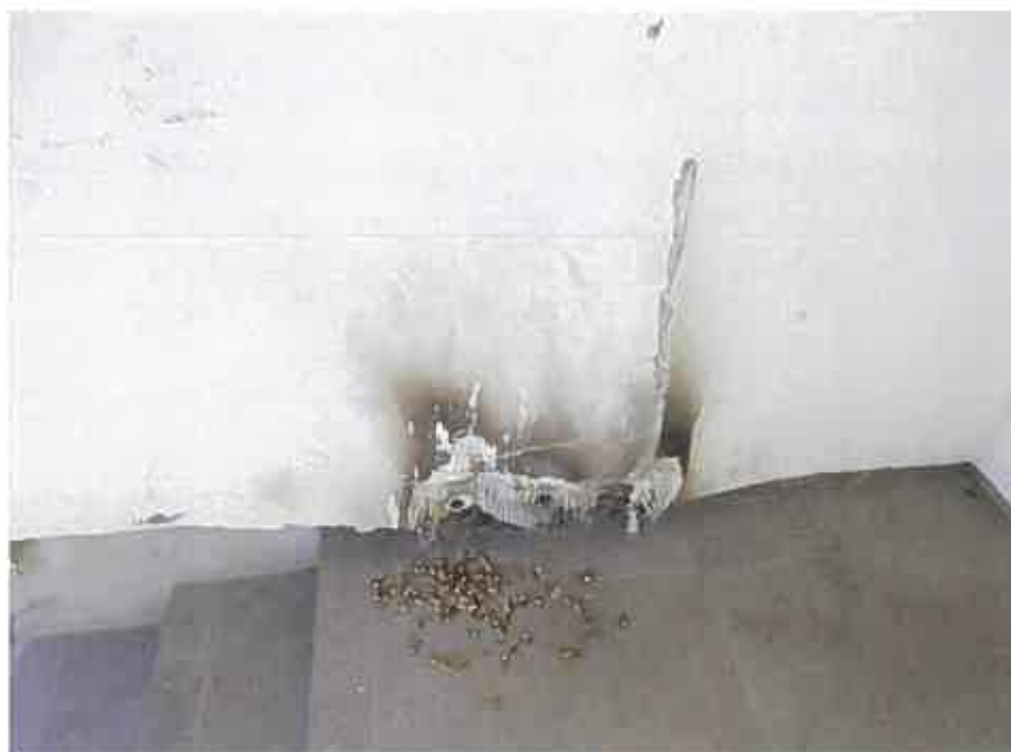
物件4: 玄関前外壁(土壁)の損傷状況
