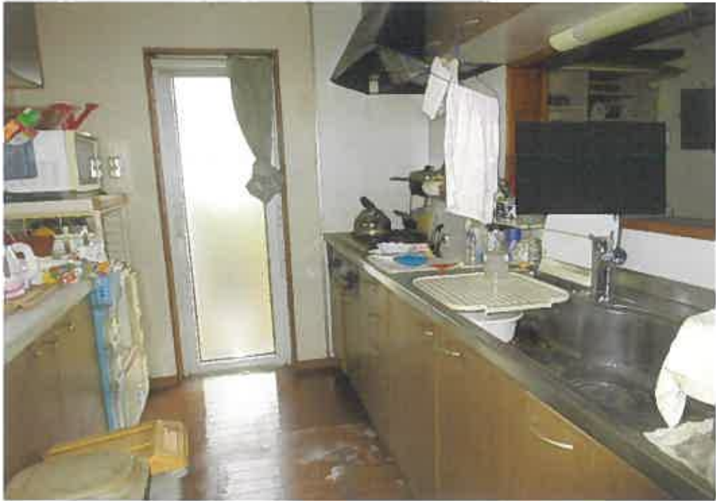
物件2:1階台所の状況
