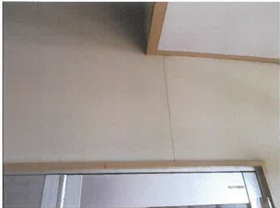
物件3:主である建物 1階廊下壁面の亀裂
