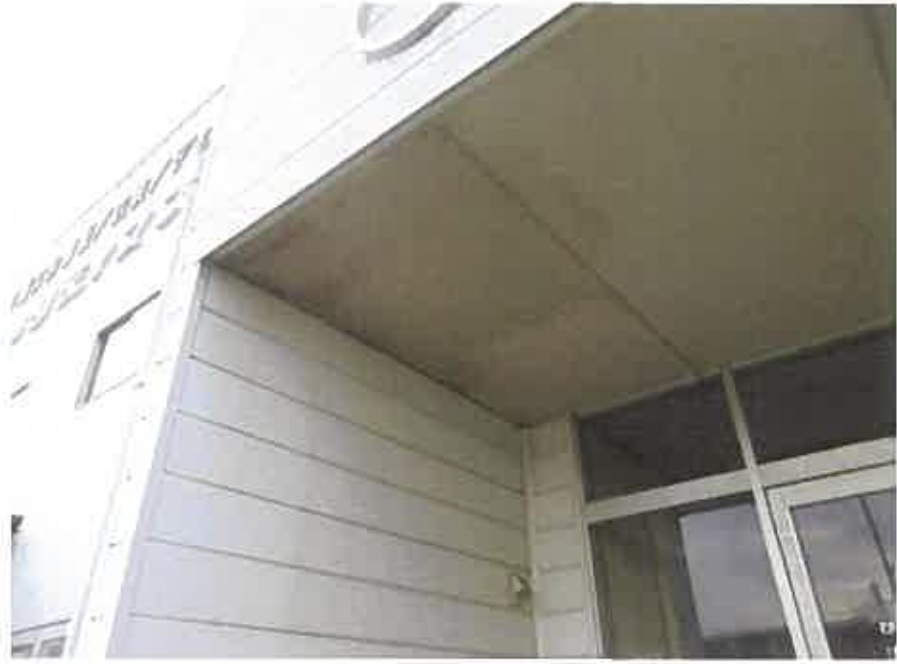
物件3:主である建物 1階エントランス天井の染み
