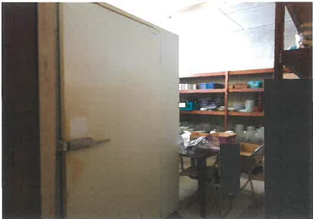
物件5専有部分の建物: 倉庫の状況
