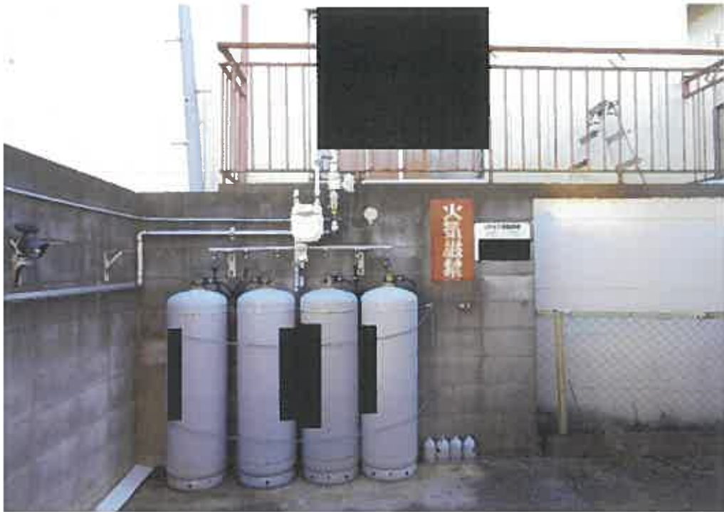
物件2土地のLPガス容器置場の状況
