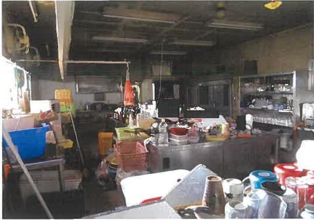
物件5専有部分の建物: 厨房の状況
