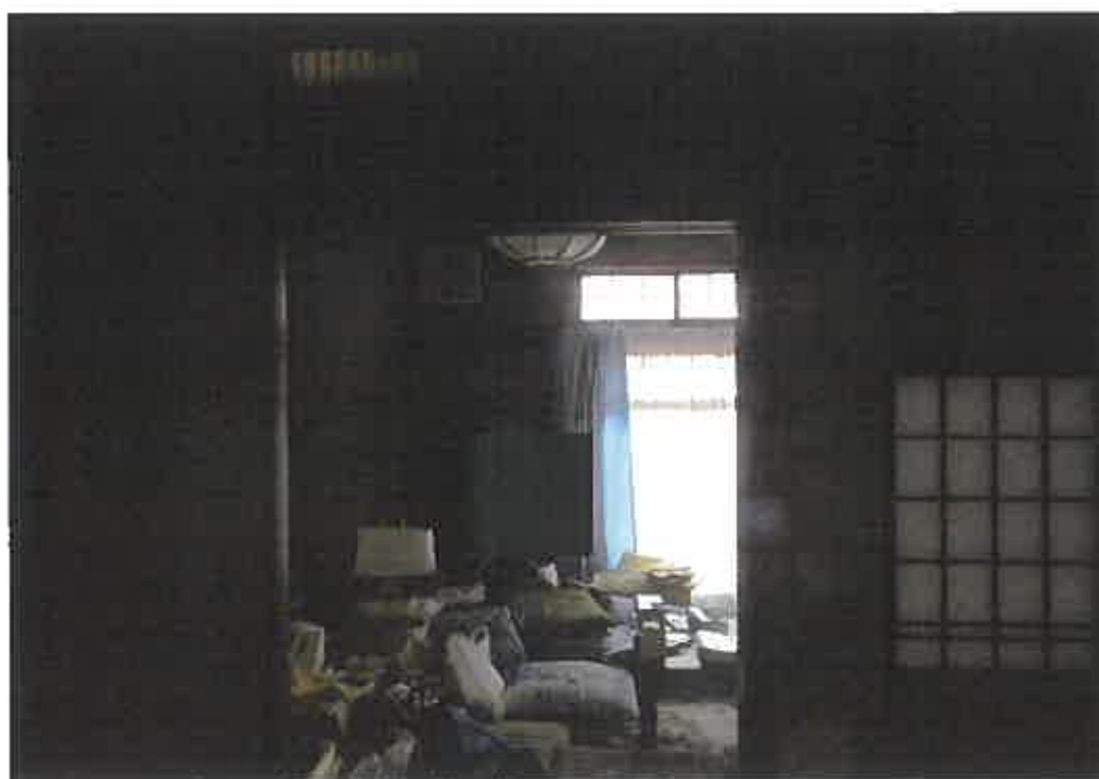
物件5附属建物符号1:引き戸扉のガラス部分の外側から撮影した内部の状況
