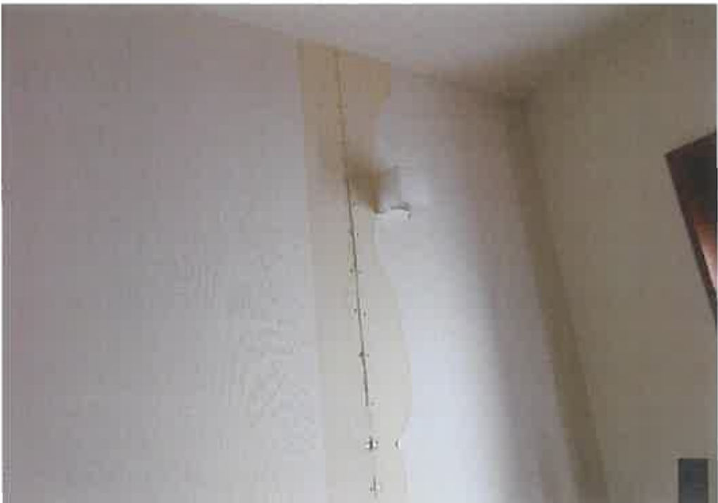
物件2:1階ホールの和室側の内壁の状況
