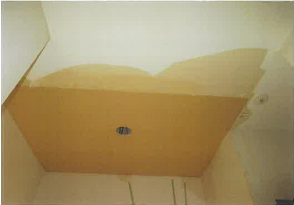
物件2:1階廊下の北側の天井の状況
