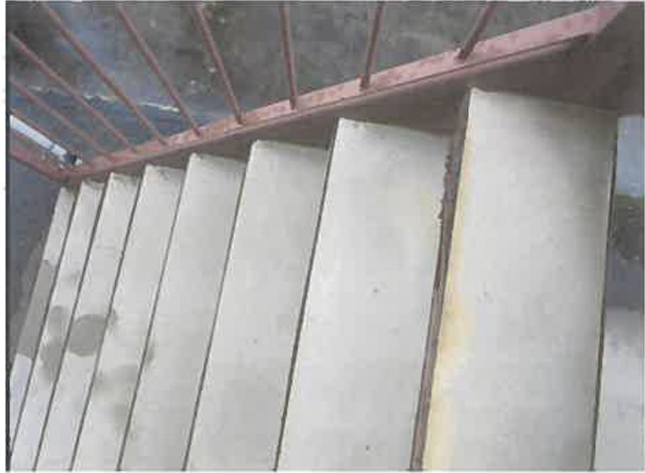
物件2:外階段の一部発錆の状況
