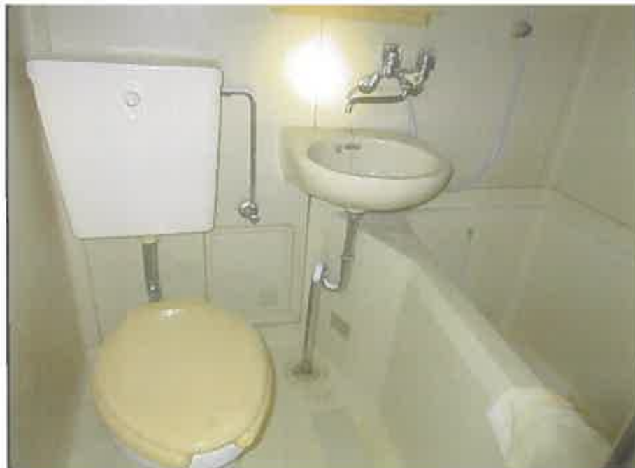
物件2:2階2-2号室 ユニットバス・トイレの状況 No. 18
