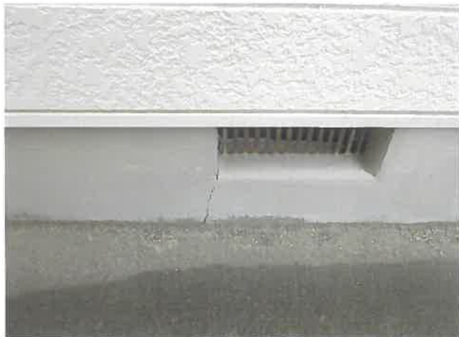
物件2:基礎部分の亀裂
