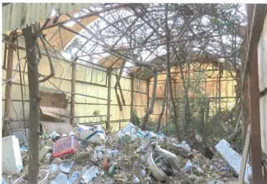
物件2未登記附属建物:内部の状況
