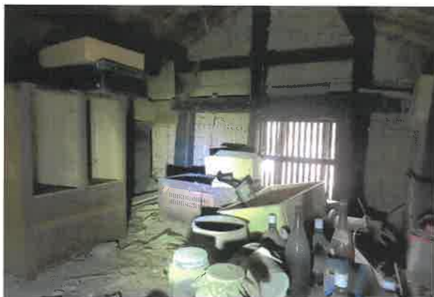
物件3:2階の状況
