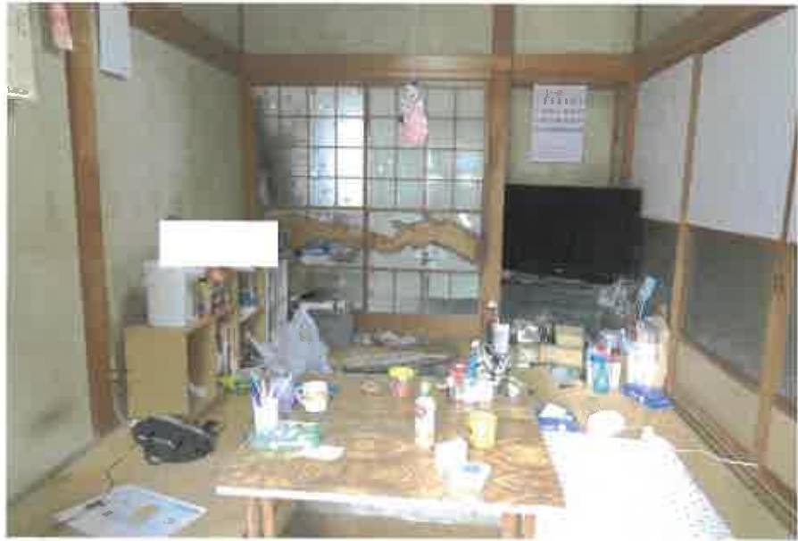
物件2主である建物:和室2の状況
