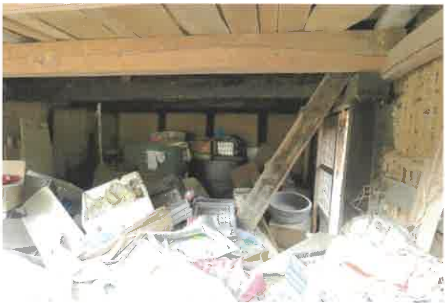
物件3:1階の状況
