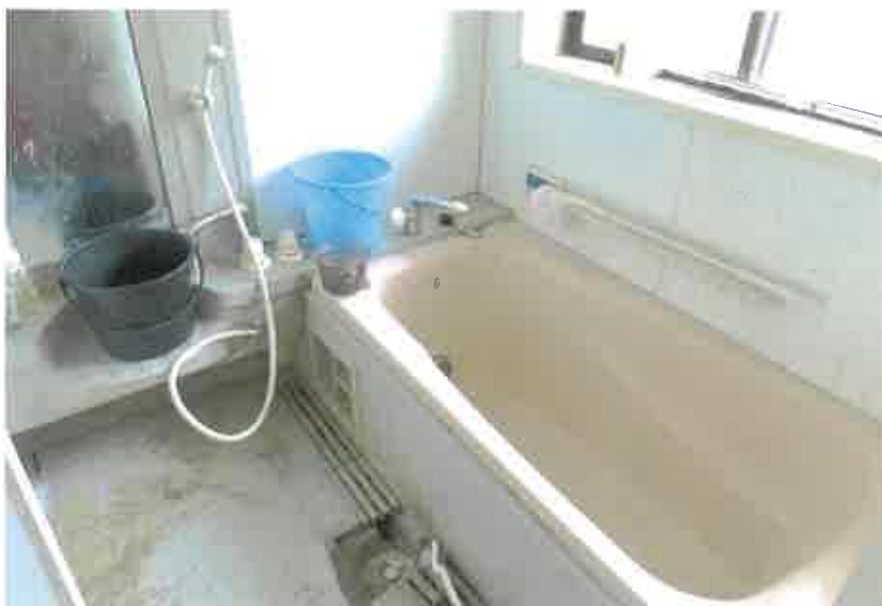
物件2主である建物:浴室の状況
