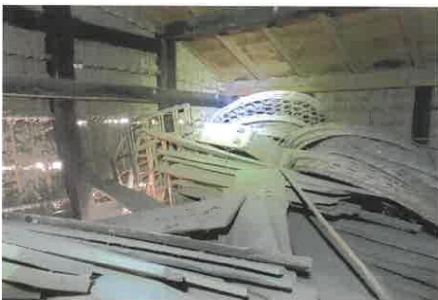
物件3:2階の状況
