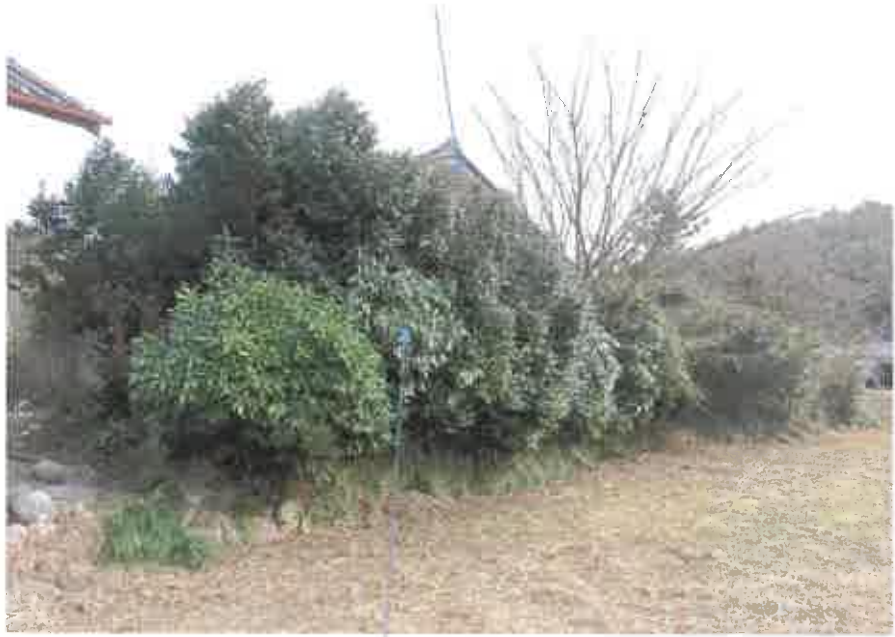
物件2主である建物
