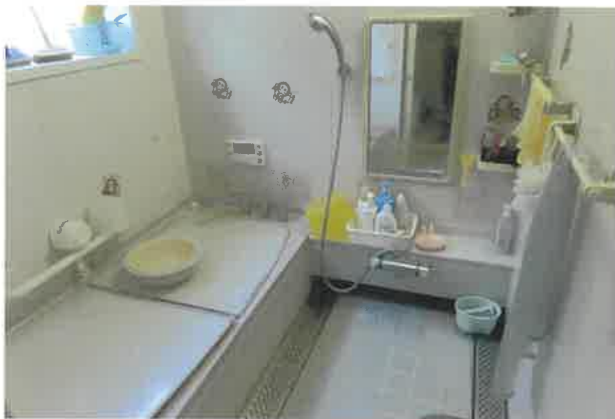
物件2:1階浴室の状況
