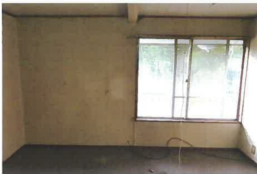
物件9主である建物:2階205号室の洋室の状況
