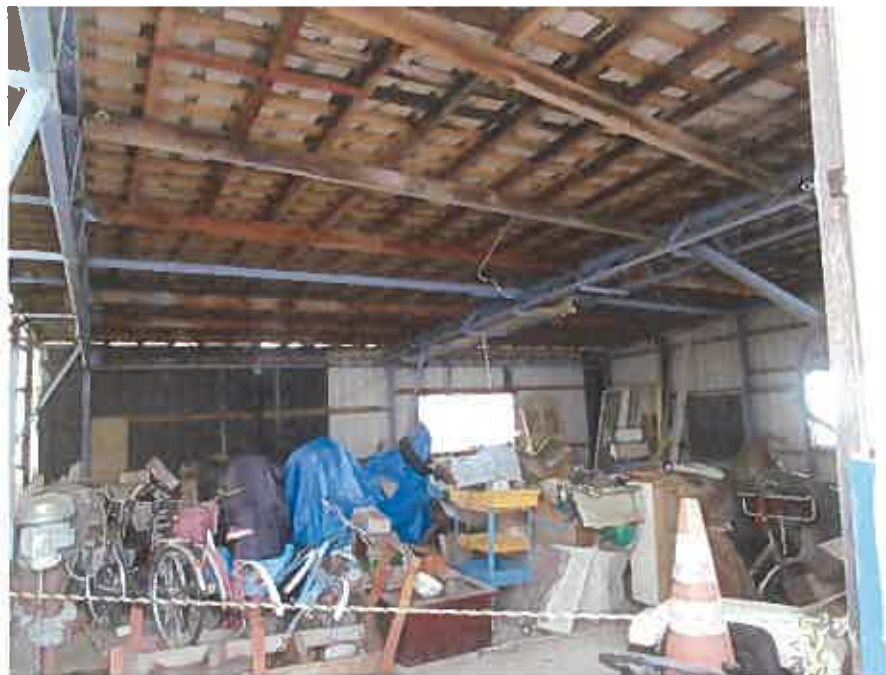
物件9未登記附属建物:内部の状況
