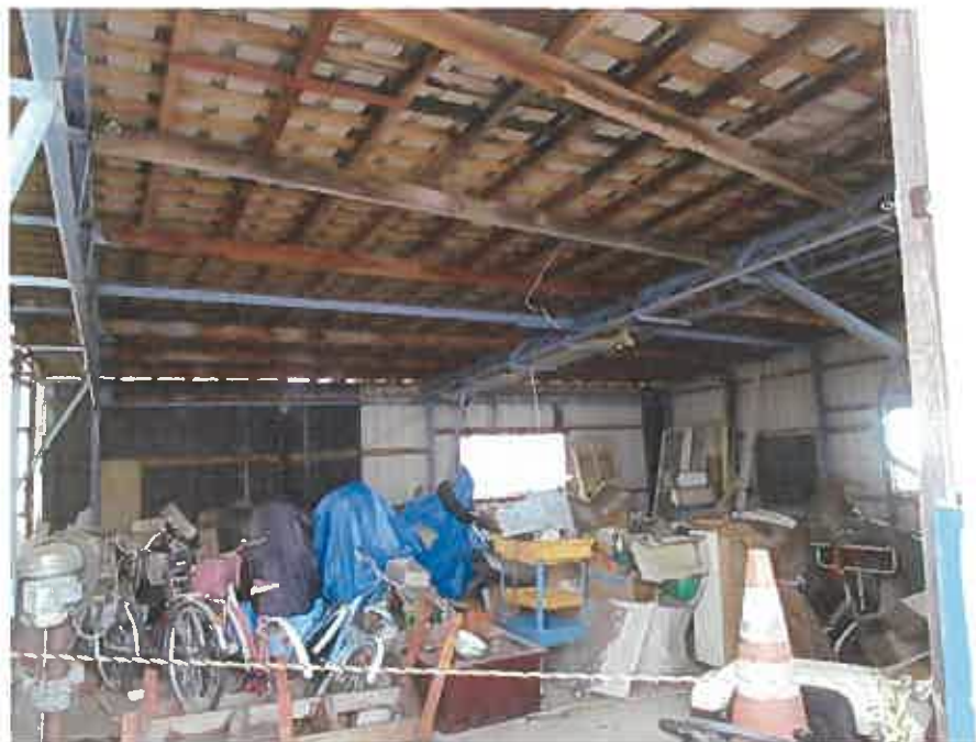
物件9未登記附属建物:内部の状況
