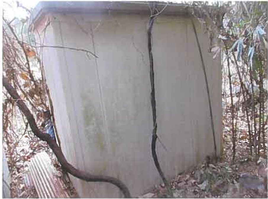
No. 7 敷地内に残置された簡易物置(内部は確認不能)
