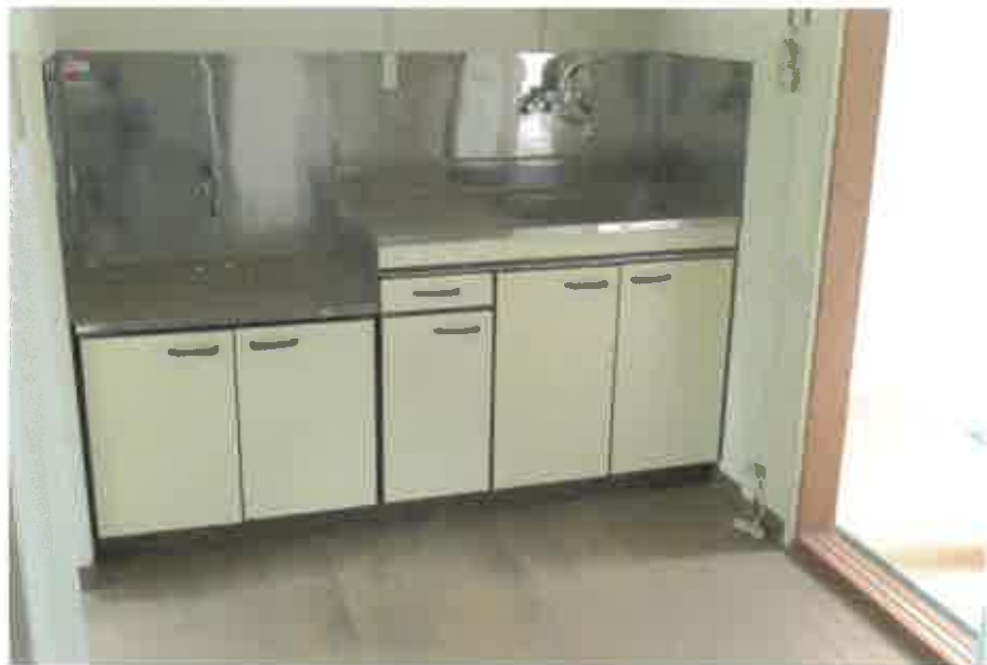
物件2:2階1号室キッチンの状況
