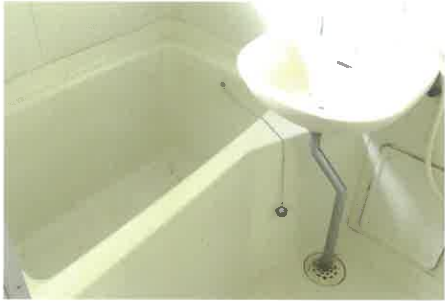
物件2:1階E号室浴室の状況
