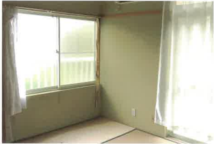
物件2:1階E号室和室の状況
