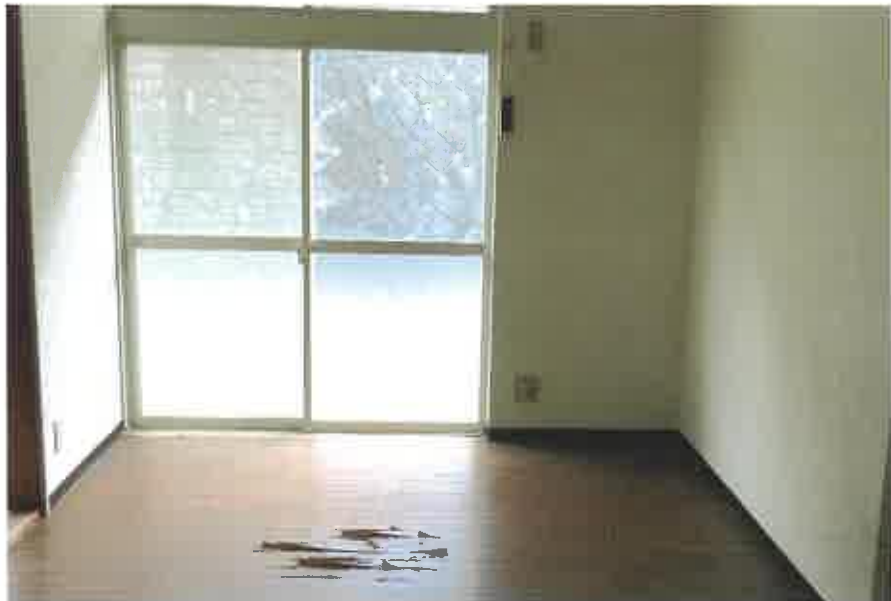
物件2:1階C号室洋室の状況
