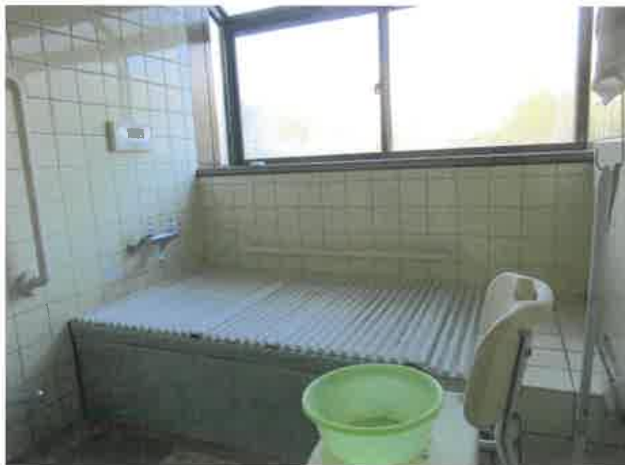
物件1:浴室の状況
