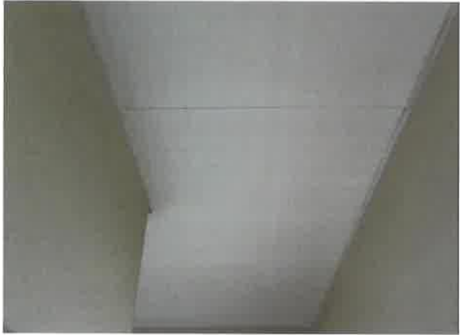
物件1：廊下天井板の亀裂
