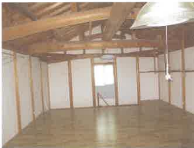
主建物 2階 板間
