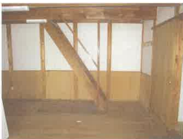
主建物 1階 板間
