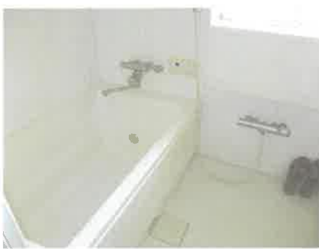
主建物 1階 浴室
