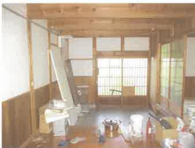
主建物 1階 土間
