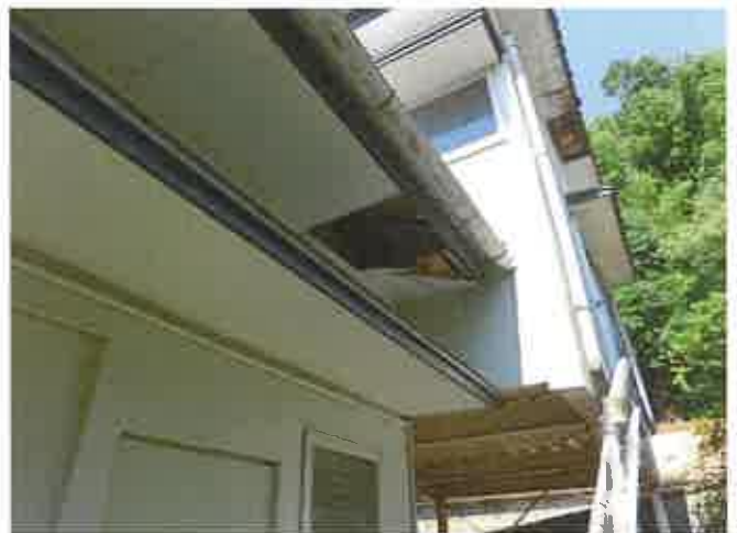
軒裏の損傷状況
