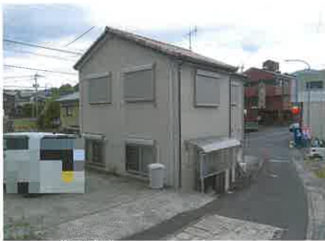
南東側の状況
