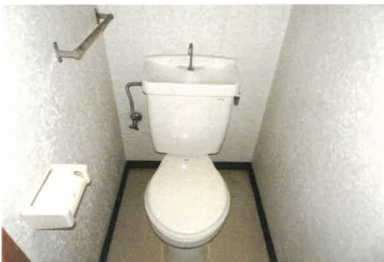
写真15 103号室内の状況
