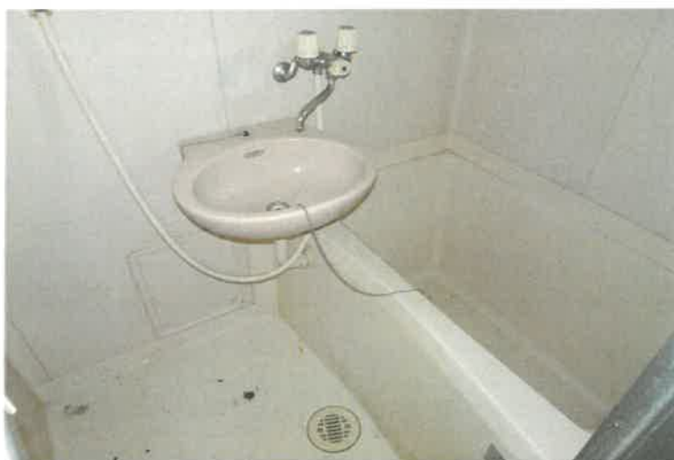
写真14 103号室内の状況
