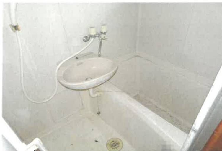
写真31 203号室内の状況
