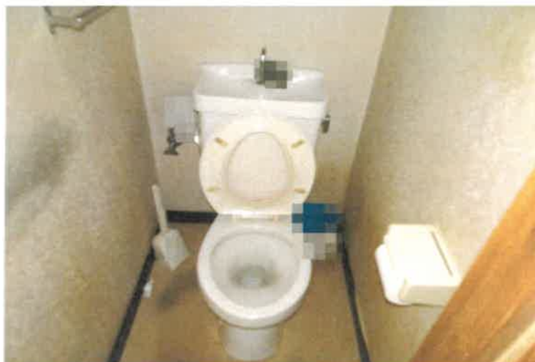
写真10 102号室内の状況
