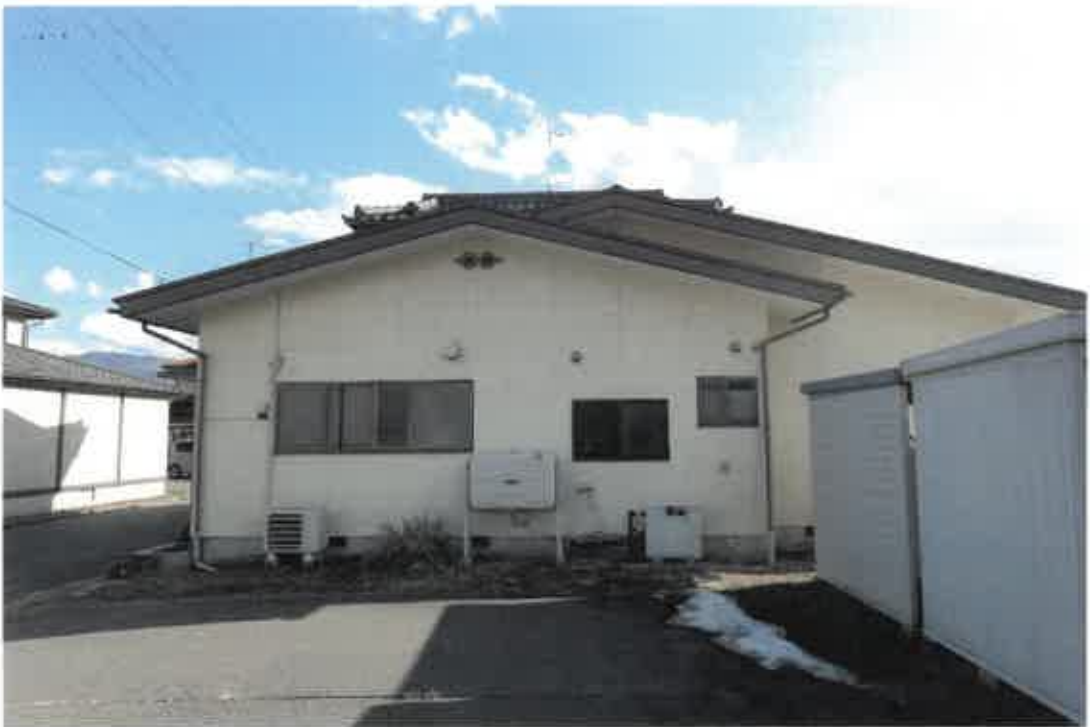
写真④（北西方向から撮影）
