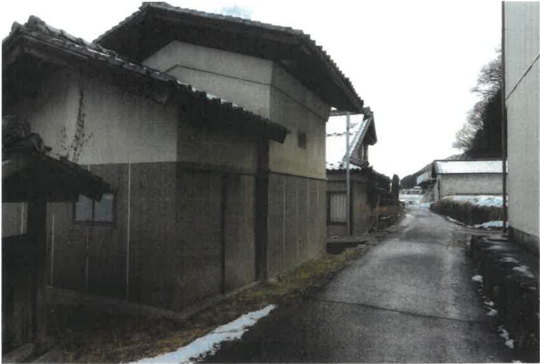
写真⑦（北方向から撮影）
