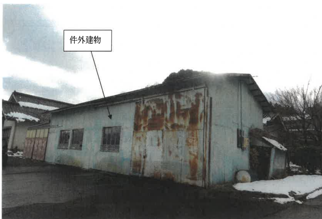
写真①（北東方向から撮影）
