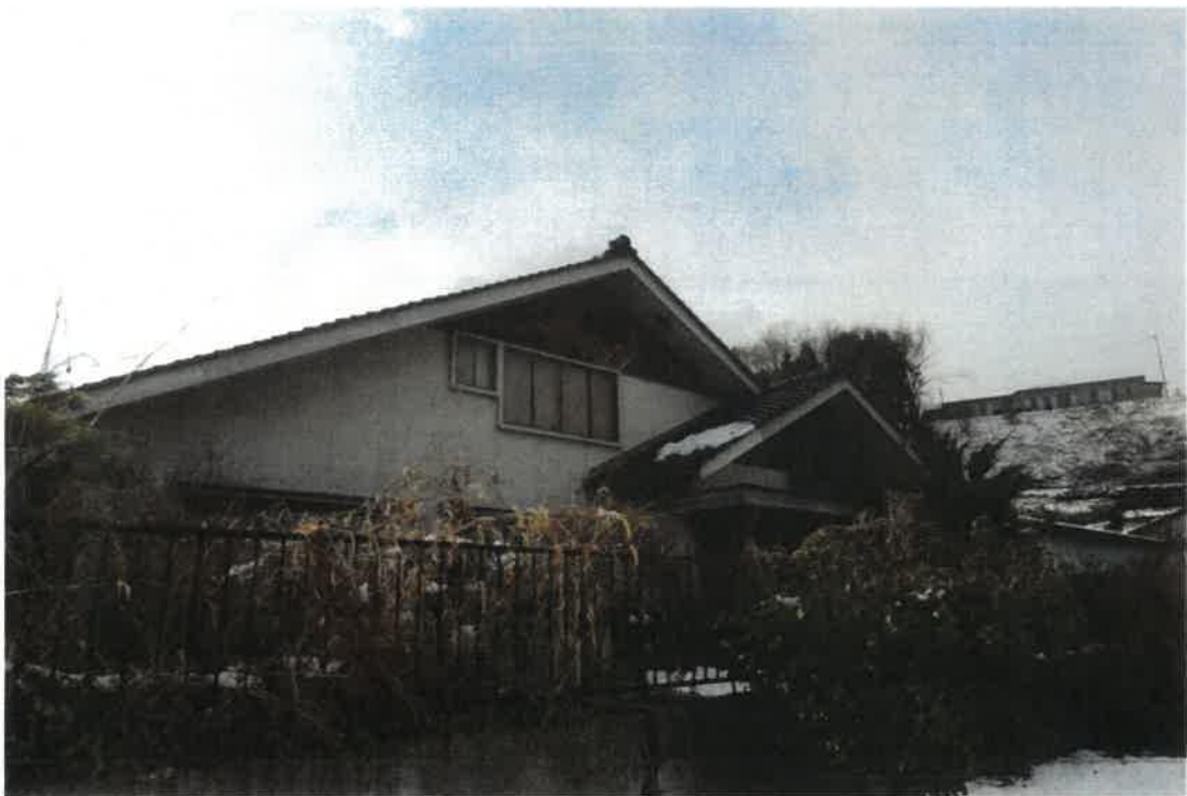
写真④（南東方向から撮影）
