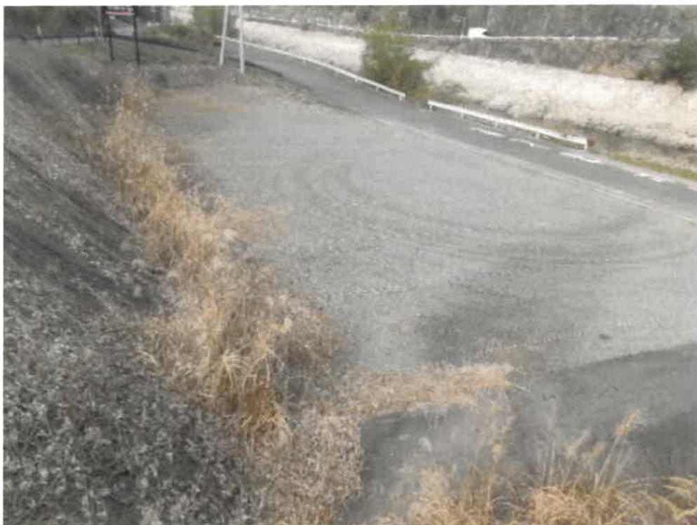
(写真6) 物件3の土地及び接面道路
