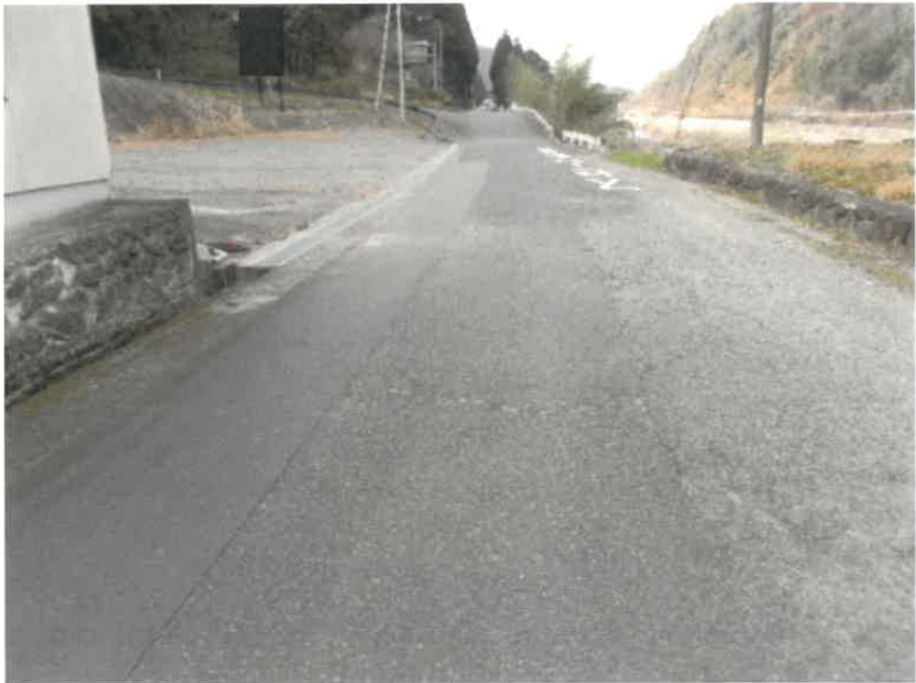
(写真11) 物件3及び4の土地の接面道路
