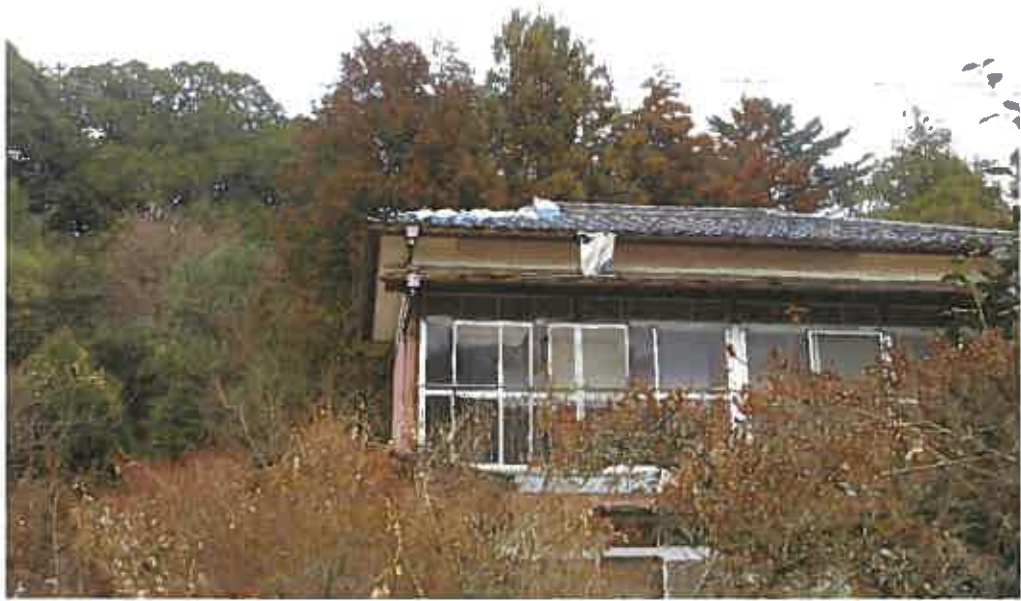
物件3主である建物の屋根の状況
