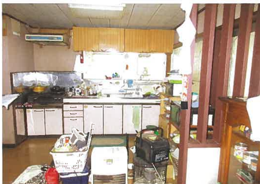
物件3主である建物:1階台所の状況
