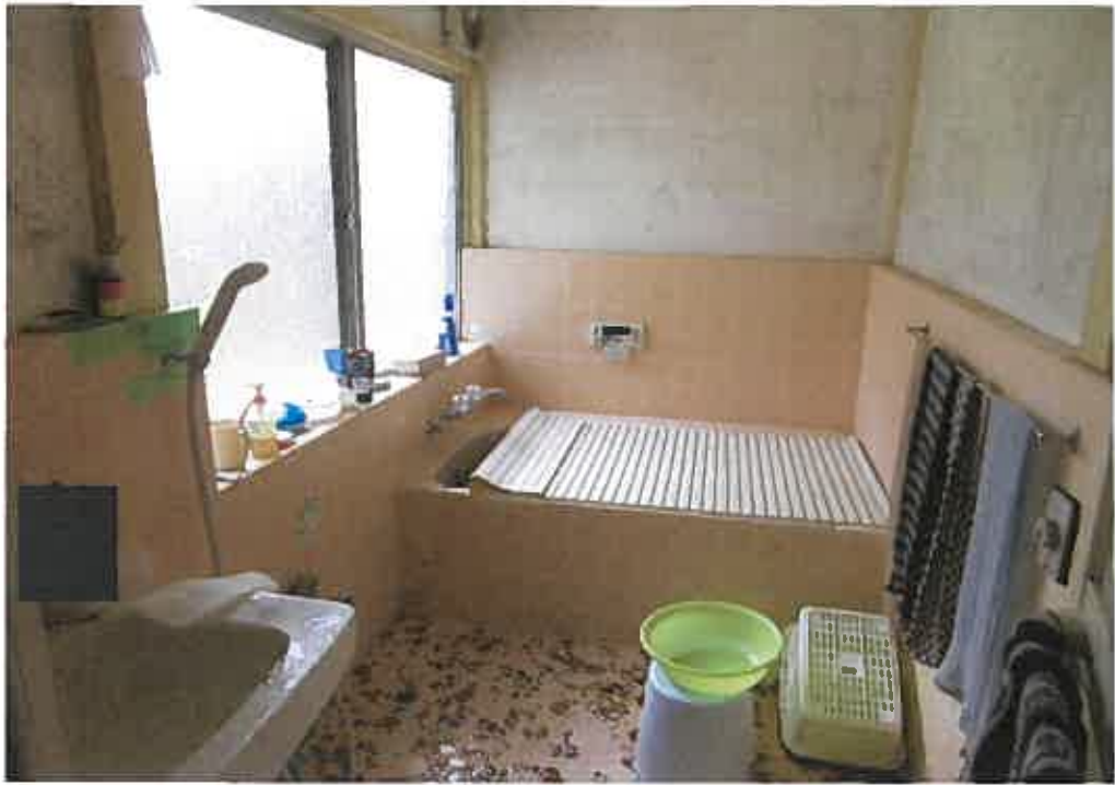
物件3主である建物:1階浴室の状況
