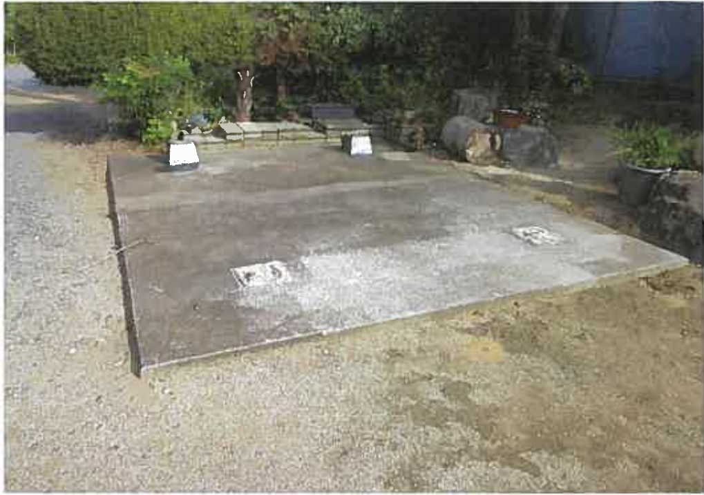
物件1コンクリートの土台の状況
