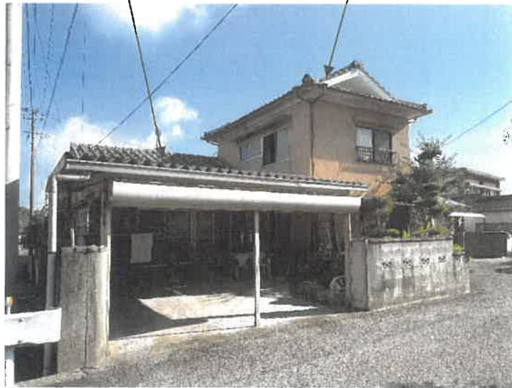
写真②ヒートポンプ給湯器
