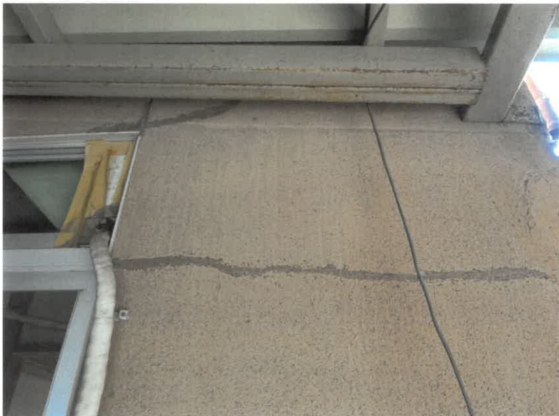
物件2（主である建物） 外壁のクラック補修跡
